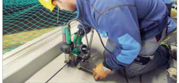
Mayor estabilidad y guía segura del aparato con el dispositivo auxiliar de guía.
