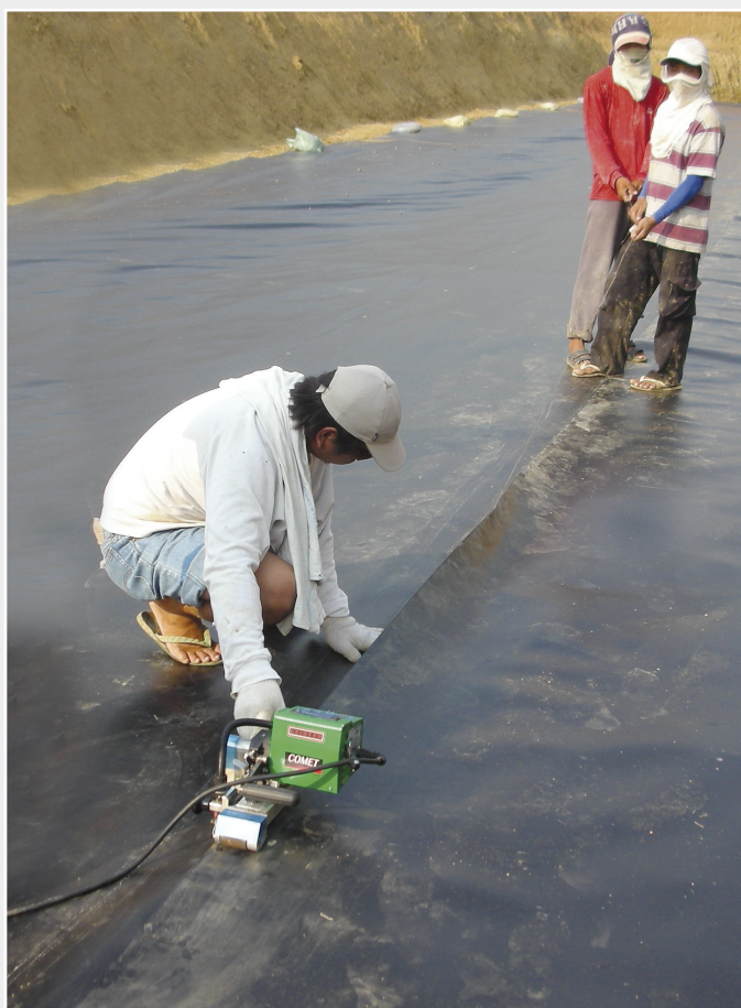
El COMET es el equipo especial para soldadura de hojas de HDPE.
