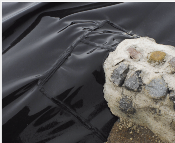
La membrana de HDPE se selló por soldadura a la línea del lodo. Este trabajo se hizo con la extrusora manual WELDPLAST 3C
