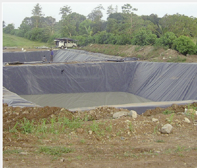
Estas cuencas tienen un tamaño de unos 4000 m 2 ; aquí se pueden apreciar antes de ser llenadas con estiércol - lodo.
