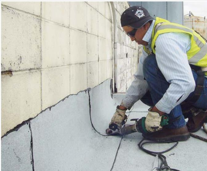
*La potente ELECTRON con boquilla de ranura ancha para la soldadura de detalles.*
