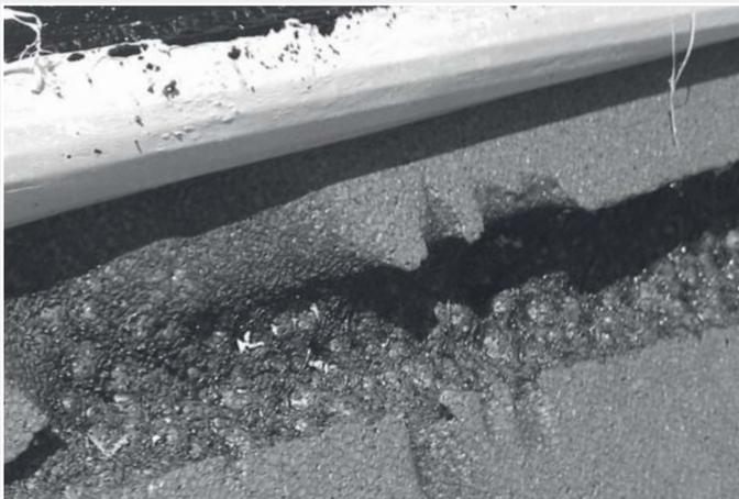
*Daño del aislamiento térmico con llama abierta. Esto se evita con la BITUMAT B2.*
