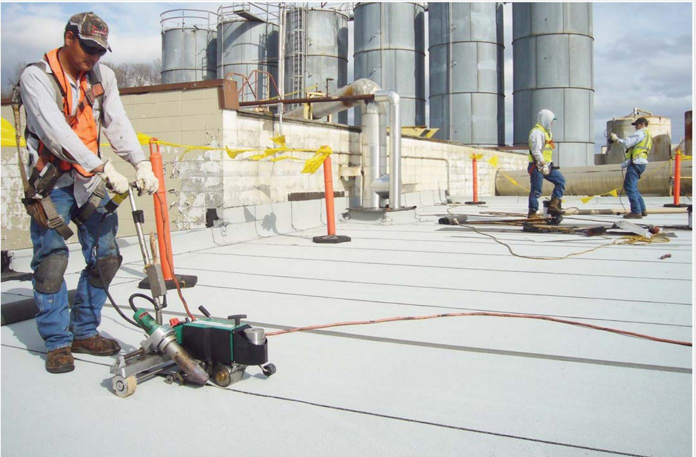
Segura y perfecta soldadura de bandas de betún con la BITUMAT B2.
