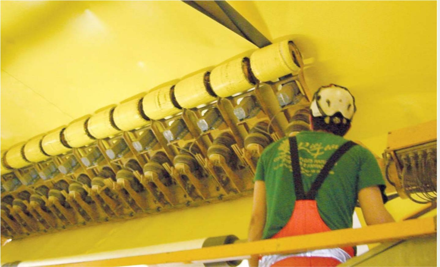
*La colocación mecánica de las bandas impermeabilizantes de plástico de 4,30 m prefabricadas en las arandelas adhesivas que se encuentran debajo. A continuación, se procede a soldar.*
