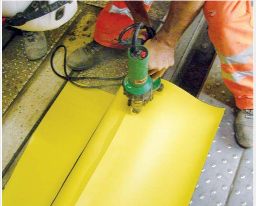
*Rodillo de presión „doble“ y boquilla de soldadura de la TWINNY S.*
