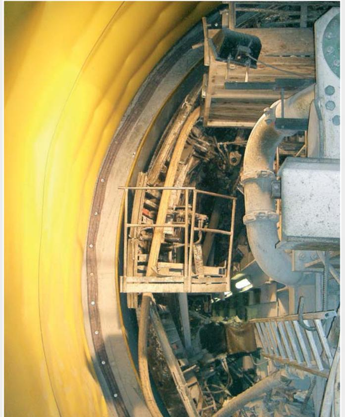
*La capa aislante ya soldada antes de aplicar el hormigón de la capa interior del túnel.*
