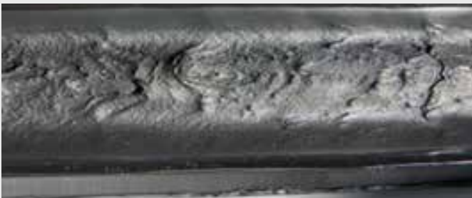
ejemplo de mala ejecución
