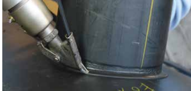
Soldadura por tracción con boquilla combinada.
