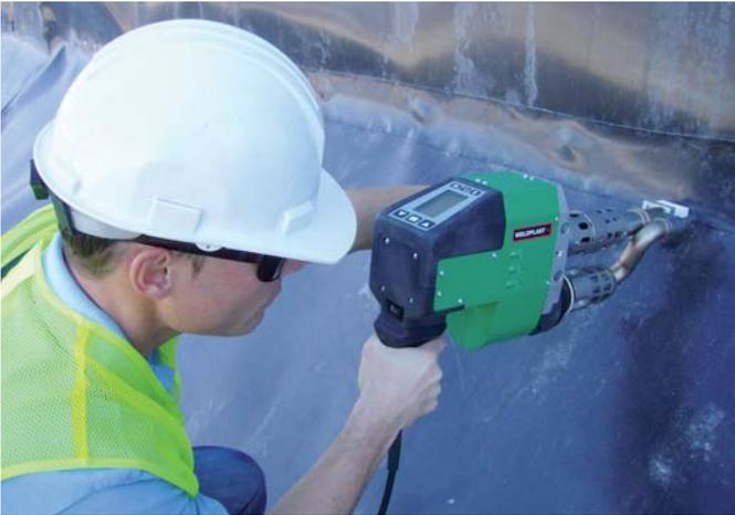
La WELDPLAST S4 uniendo las membranas impermeabilizantes de plástico del borde de la orilla.
