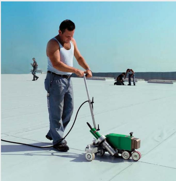
Con las herramientas de Leister, Columbia River Roofing logró colocar y asegurar entre 2.000 y 2.300 metros cuadrados de tejado por día. Todas las juntas se sellaron con la soldadora VARIMAT V de Leister.
